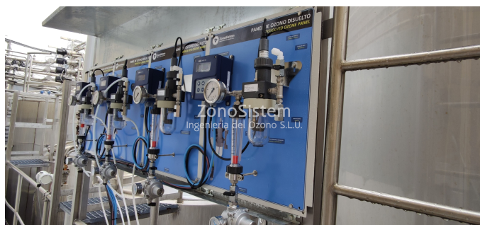
Detalle analizadores de ozono disuelto proyecto CIP, España.
