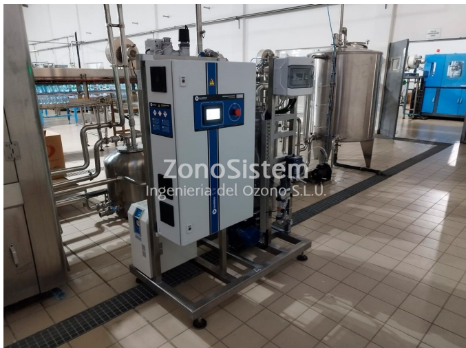
Ozono en CIP de embotelladora de agua, Senegal.
