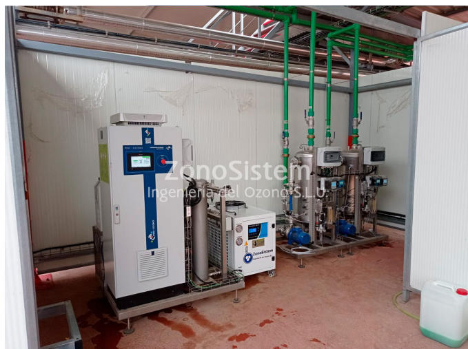
Ozono para desinfección de superficies industria cárnica, España.
